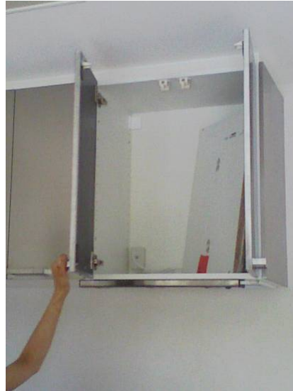
収納棚には耐震ラッチ
