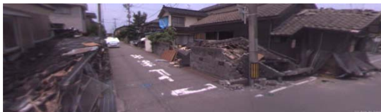
2007年新潟県中越沖地震 柏崎市内の被害状況 (2007.7.19 アジア航測株撮影)
