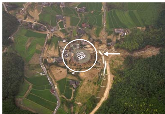
図-2 防府市真尾特別養護老人ホーム「ライフケア高砂」被災状況(7/22アジア航測撮影)
