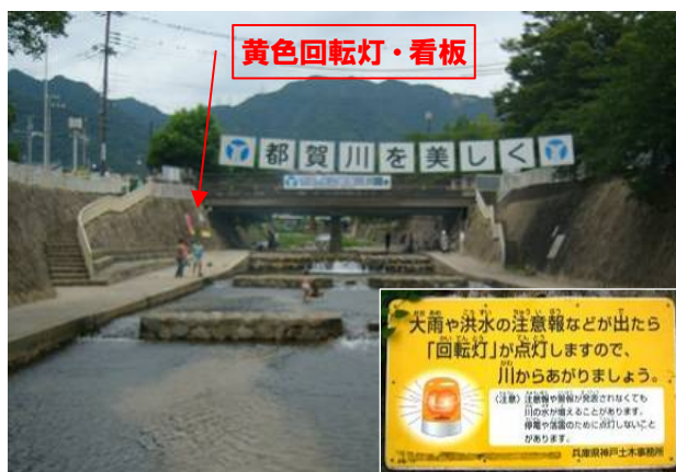
図2 水難事故後の神戸市灘区都賀川の安全対策
