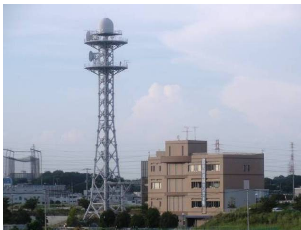
図3 横浜市港北区に新設されたXバンドMPレーダ (国交省関東地整京浜河川事務所新横浜出張所)
