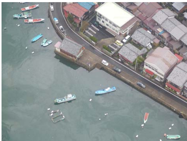
写真1 地震発生後(2004.9.6)の状況。漁船の転覆、油の流出が認められる。
