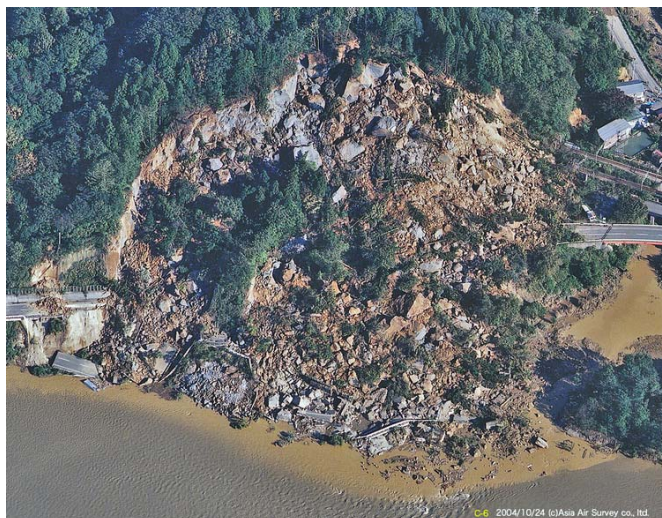
写真.2 新潟県中越地震による県道被害(小千谷市浦柄 白岩、04.10.24 アジア航測撮影)
