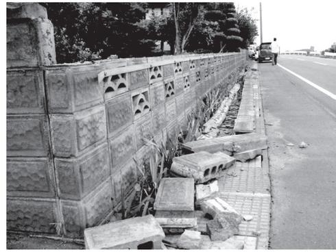
写真2 倒壊したブロック塀（栗原市内）
