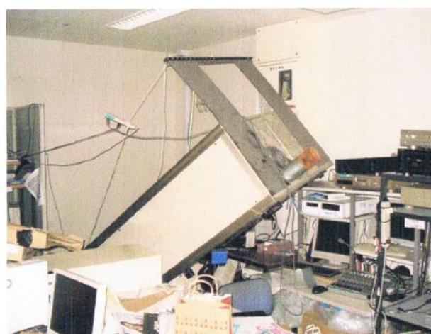
図 2.2 fmいずみ局内の被害状況(マスターが倒れた)
